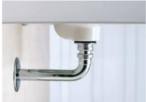
Uygun olmayan sifon bağlantısı
