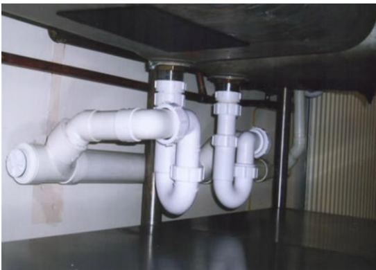
Şekil-4.3: Borulu ve şişe tipli sifonlar
